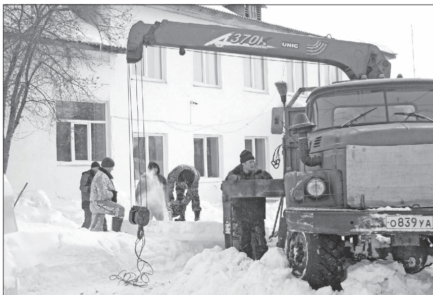
А около районного Дома культуры идет строительство новогоднего ледового городка.
